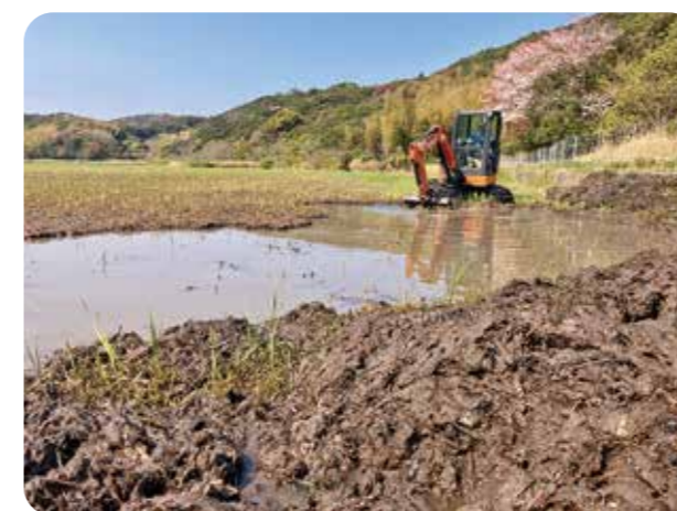
手前が除去したスポンジ層 2023年4月
